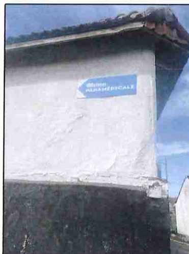
Pré-enseigne sur mur aveugle
